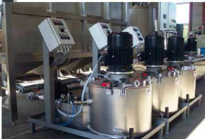
Installation centralisée de filtration d'huile de centrale avec 3 centrifugeuses manuelles
